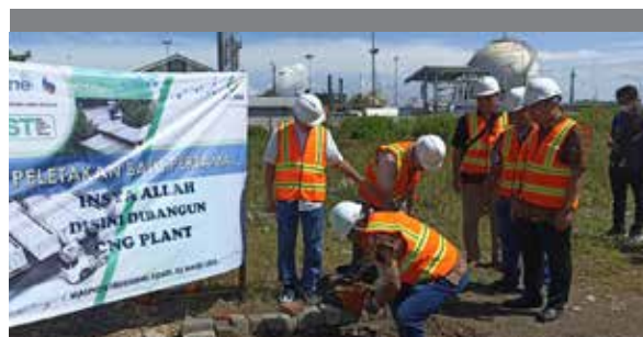
Peletakan Batu Pertama Stasiun CNG Manyar, Gresik Jawa Timur Groundbreaking of Manyar CNG Station, Gresik East Java
